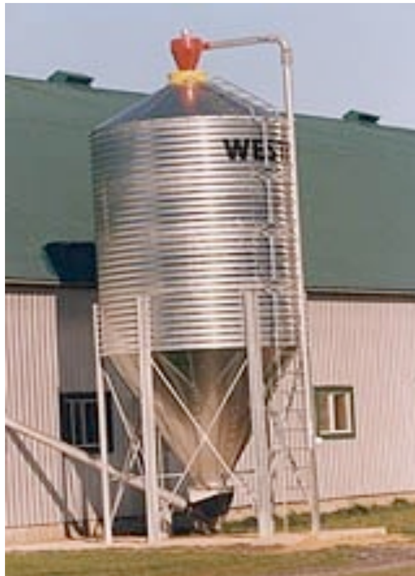
Silo à grains
